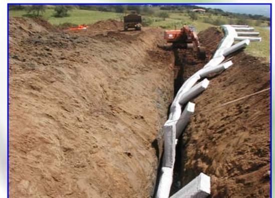
Foto 3 – Fortschreiten der Grabungsarbeiten und gleichzeitiger Einbau der Dränagelinie
