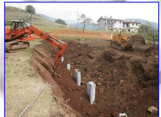
Foto 4 – Auffüllung des Aushubgrabens, man beachte die Sicktürme
